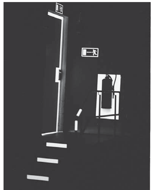
Bild 5: Beispiel einer Kennzeichnung mit Leuchtbändern (Situation bei Dunkelheit)
