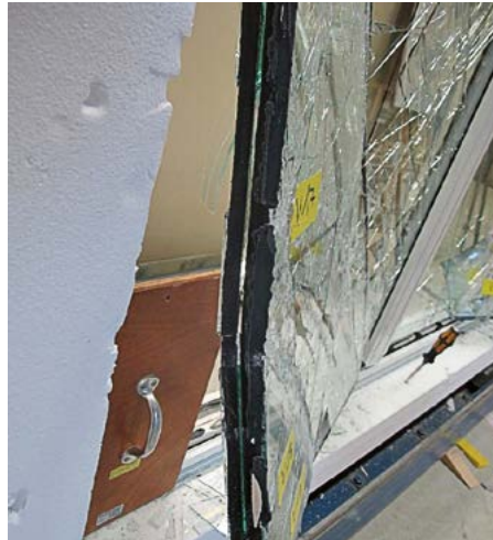
Abb. 7: Manuelle Prüfung der Glasanbindung. Es wurde eine durchgangsfähige Öffnung erreicht.
